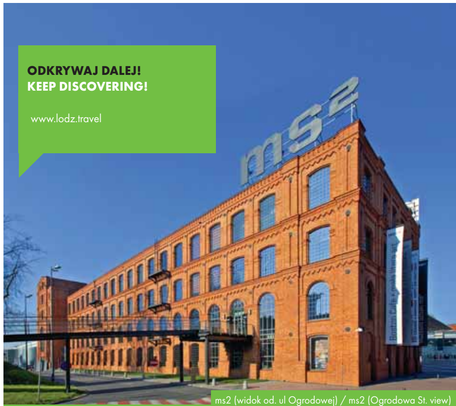
ms2 (widok od. ul Ogrodowej) / ms2 (Ogrodowa St. view)
